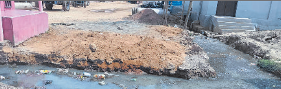
लोहारा। पुराना शहर के बाल्मीकि चौक पर पुलिया निर्माण के लिए की गई खुदाई और उसमें जमा गंदा पानी।
